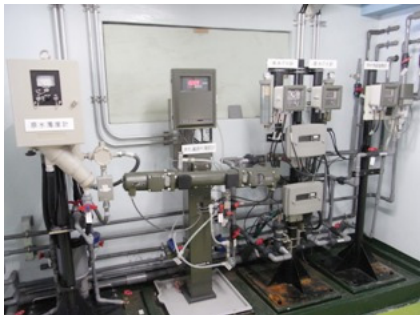
↑ 青葉第二浄水場内「設備機器」
