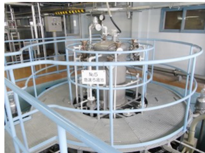
↑ 青葉第二浄水場内「設備機器」
